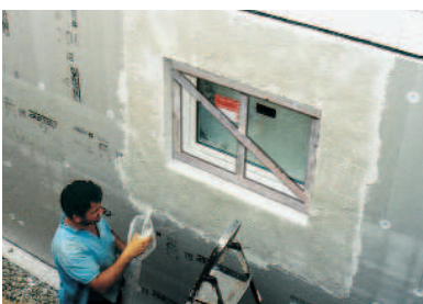
A tartókeret a szerkezetépítési fázisig a helyén marad a károsodások elkerülésére
