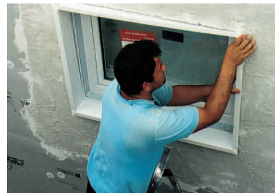
Összeállított szigetelécscsatlakozó-profil behelyezése a falburkolási munkák befejezése után a zsaluzatszigetelés eltávolítását követően keletkező horonyba.
