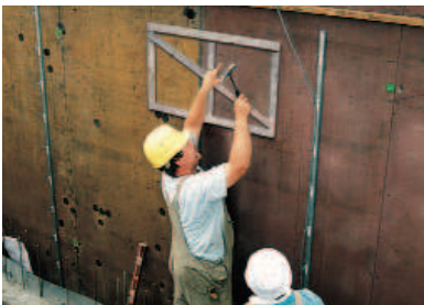
A tartókeret rögzítése a zsaluzaton
