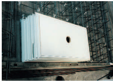
A vasalás befejezése után, közvetlenül a betonozás előtt helyezik be a külső szerelési lappal védett ablakot. Rendszerint nincs szükség kiegészítő ellentartásra.
