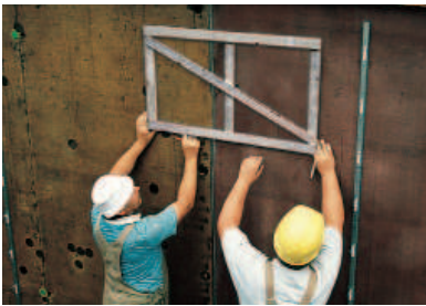
Tartókeret vízszintezése a megfelelő magasságban
