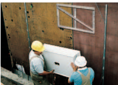
Az ACO Therm® ablak ráhelyezése a rögzített tartókeretre és biztosítása az ablakon kialakított perforált szalagokkal
