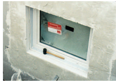
A szigetelécscsatlakozó-profil könnyen, szerzőszám alkalmazása nélkül be lehet illeszteni az adott helyen szükséges szigetelés vastagsághoz: 100, 80, 60 vagy 110-200 mm
